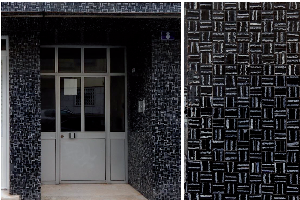
Figure 18: Rua Cândido dos Reis N° 8, Amadora
