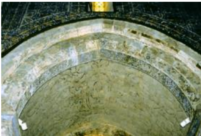
Figura 3 – Abóbada na igreja do antigo Convento de Santa Maria de Almoster, em Santarém, observando-se o revestimento integral a azulejos brancos preenchido com motivos pintados a ouro.
