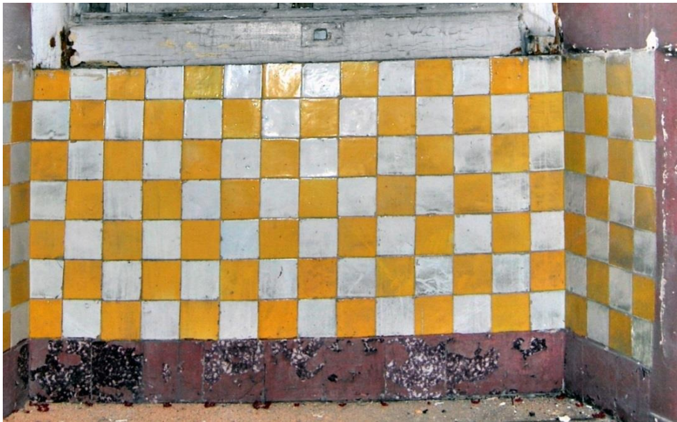
Figura 7- Axadrezado de azulejos de pequena dimensão utilizado pela Fábrica Roseira em diversas combinações de cores. Estes pequenos azulejos amarelos foram utilizados, tanto no Beau Séjour , como no Palácio Pena (aqui datados de 1867) em revestimentos exteriores.
