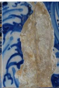
Figura 2b- Crostras salinas e desagregação da chacota por empolamento.
