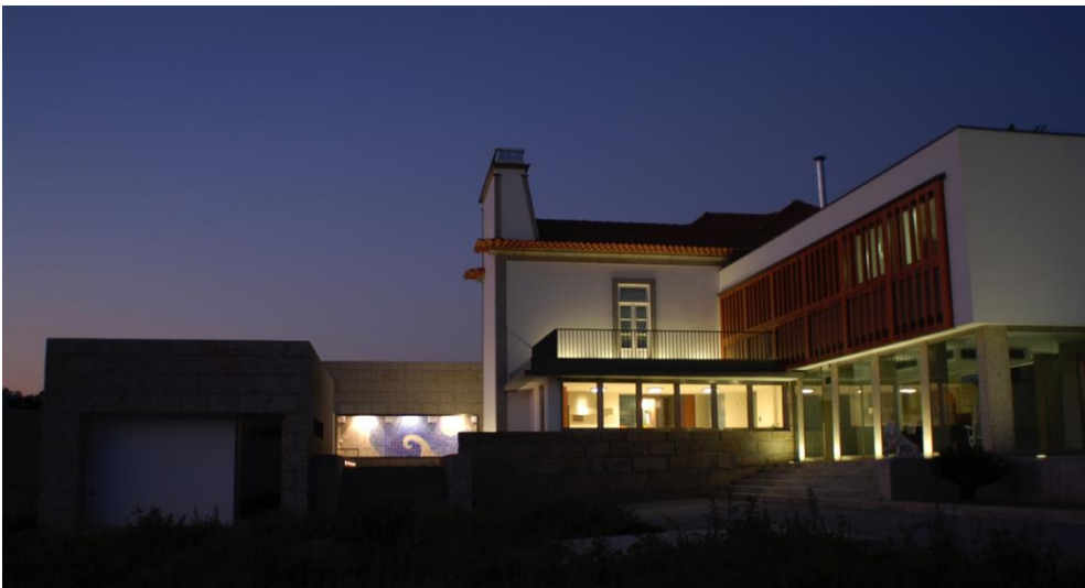
Fig. 6: Vista do exterior. Fotografia: Ana Paula Pinheiro.
