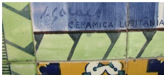
Figura 22: Pormenor da moldura que acompanha os painéis que decoram a Estação da CP de Évora evidenciando as marcas de trincha características da utilização de estampilhas.
